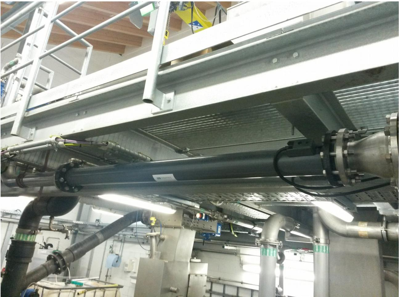
Abbildung 4: ZetaOptimizer, integriert in der Dünnschlammleitung unterhalb einer Dekanterbühne, vor der Polymerdosierung
